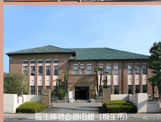
桐生織物会館旧館(桐生市)
