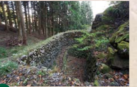
荒船風穴 国指定史跡。1905 (明治38)年から大正にかけて建設。養蚕の多回数化のため、蚕の卵の蚕種を夏季に貯蔵した天然の冷蔵施設。貯蔵能力は国内最大。旧上野鉄道を使って全国から送られた蚕種を貯蔵した。
