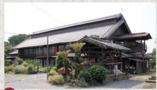
D 田島弥平旧宅・境島村養蚕農家群 瓦屋根に換気設備を取り付けた近代養蚕農家の原型
