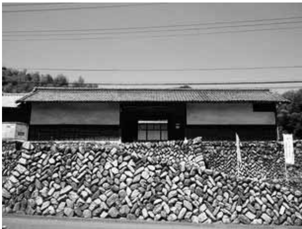
解体前の長屋門
