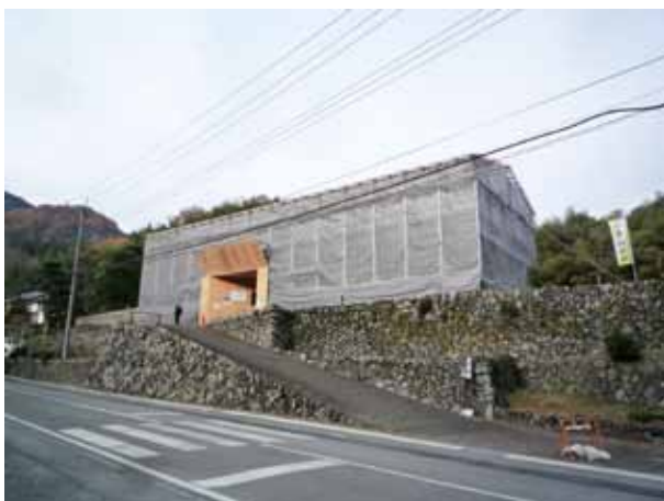
高山社跡・長屋門解体修理
