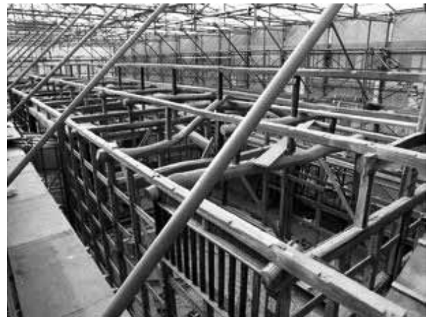
長屋門の解体作業の様子
