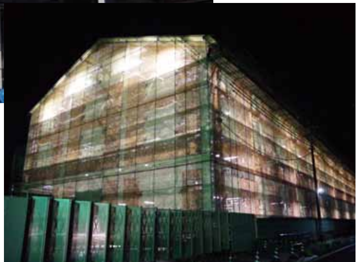
日没後の作業のために照明が点灯
