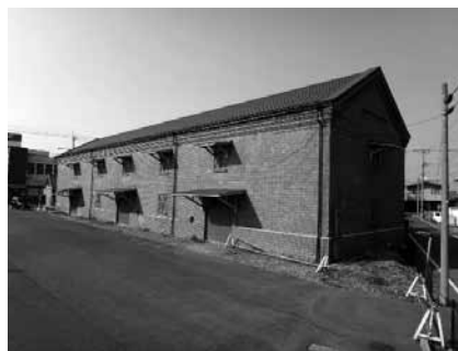
境赤煉瓦（レンガ）倉庫
