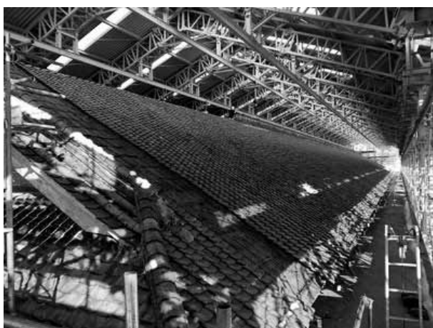
西置繭所の解体工事（素屋根の内部）
