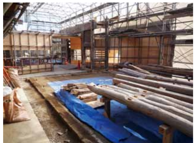
長屋門解体状況
