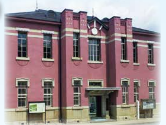
旧模範工場桐生燃糸合資会社事務所棟
