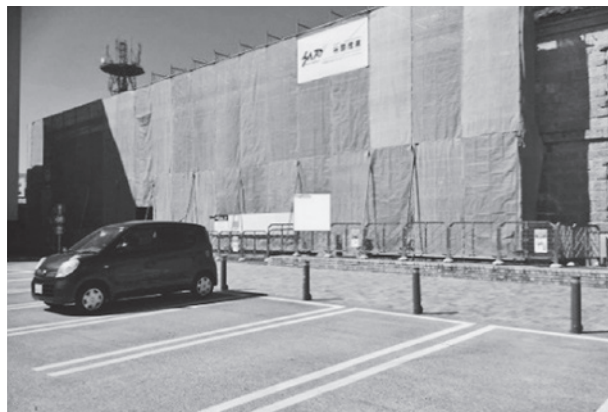
1号倉庫外観改修工事中写真
