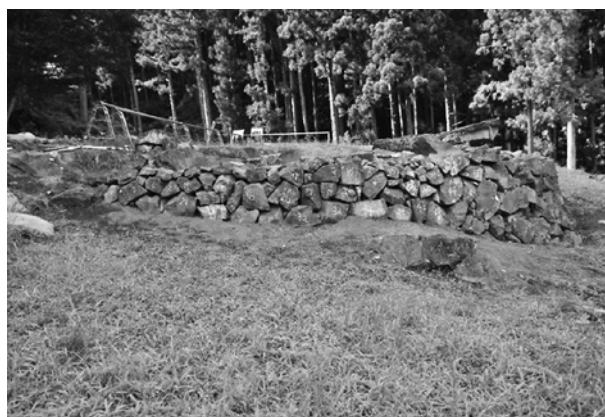
池南側石積み 修復後
