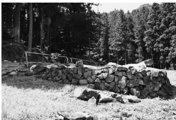
池南側石積み 調査・修復前
