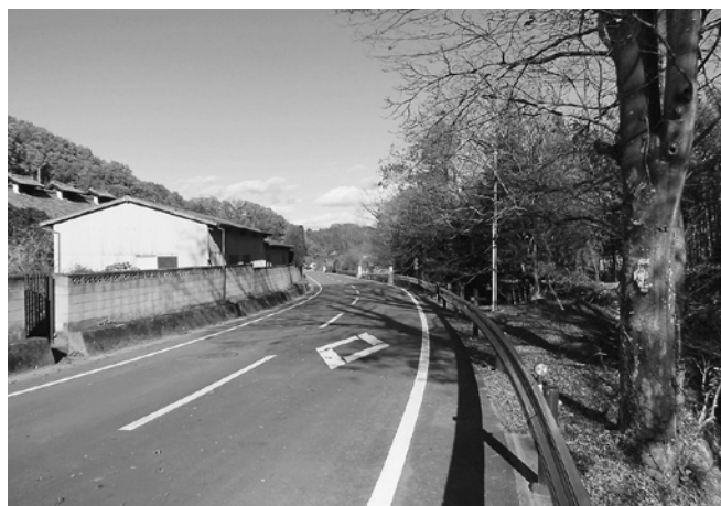
県道下日野神田線（電線地中化工事後）
