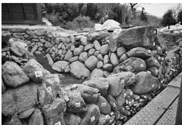
石垣石積みの状況調査
