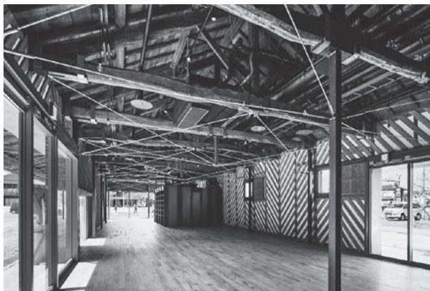
3号倉庫竣工後内部写真
