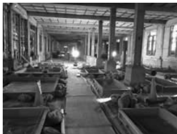
1 階耐震補強基礎施工状況
