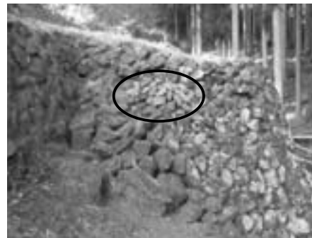
3号風穴東側はばき石積み修復後
