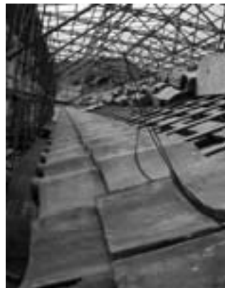
瓦葺き工事の様子
