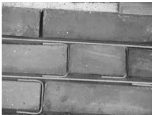
煉瓦壁アラミドロッド補強
