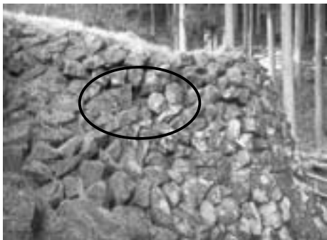
3号風穴東側はばき石積み修復前
