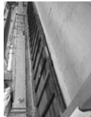
外部下見板取付後
