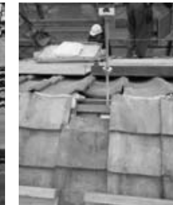
棟積み内部耐震補強金具設置状況
