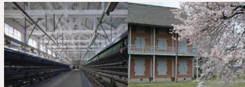
▲Interior de la planta de devanado
