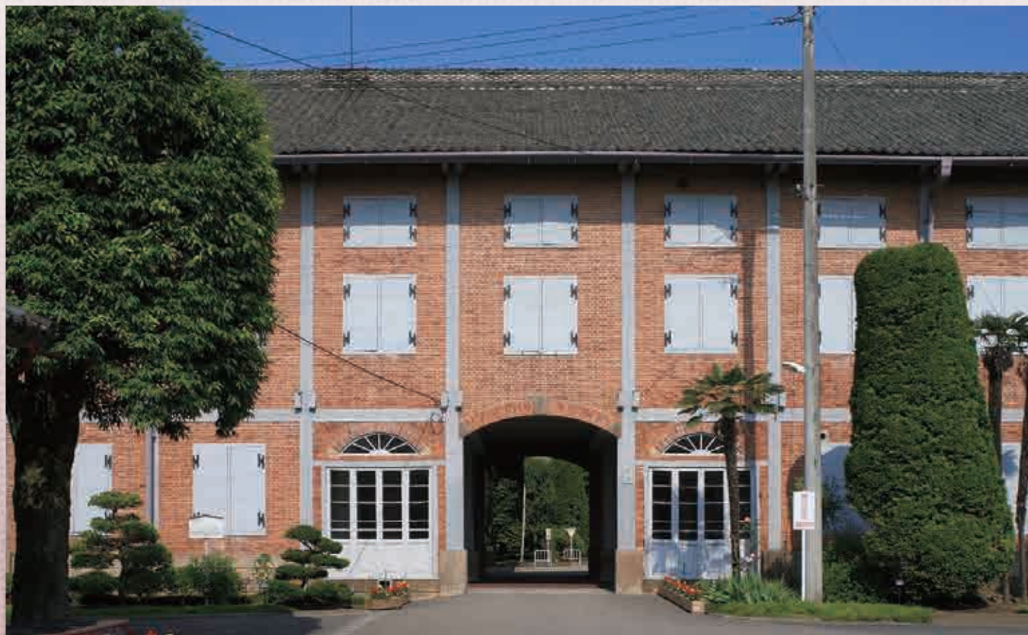
▲Almacén de capullos del este
