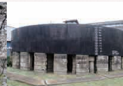
▲Depósito de agua de hierro
