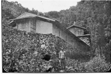
写真11 2号風穴北側⑮⑯用地付近
