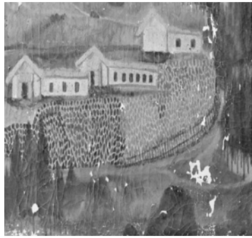
写真12 大正期番舎作業場跡
