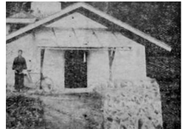
写真10 3号風穴前建築材搬送路
