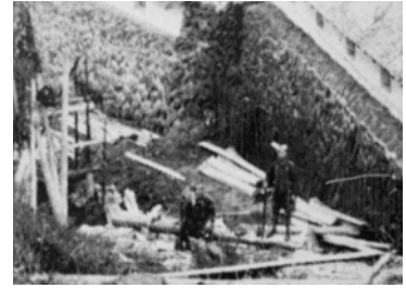
写真8 木挽きと建築材作業場
