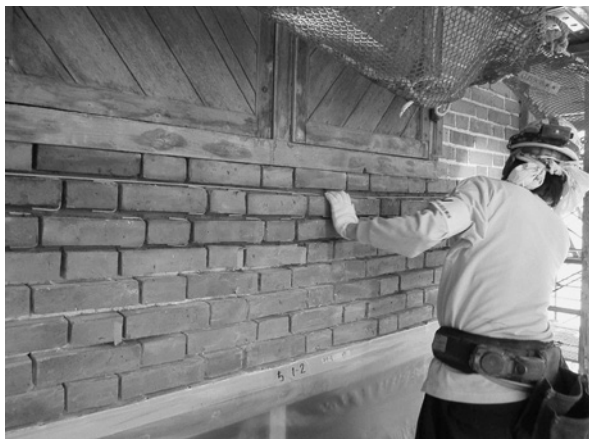
【写真3】アラミドロッド目地補強（画像提供 富岡市・富岡製糸場）
