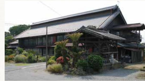
通風を重視した蚕の飼育法「清涼育」を大成した田島弥平が、文久3年(1863)に建てた住居兼蚕室です。間口約25m、奥行約9mの瓦葺き総2階建てで、初めて屋根に換気用の越屋根が付けられました。この構造は、弥平が「清涼育」普及のために著した、『養蚕新論』『続養蚕新論』によって各地に広まり、近代養蚕農家建築の原型になりました。
