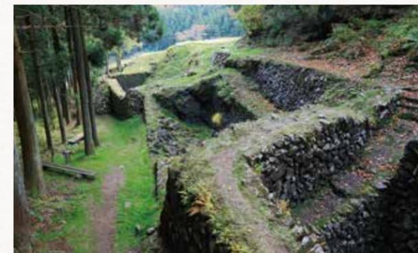
明治38年(1905)から大正3年(1914)頃に造られました。岩の隙間から吹き出す冷風を利用した蚕種(蚕の卵)の貯蔵施設で、冷蔵技術を活かし、当時1回だった養蚕を複数回可能にし、繭の増産に貢献しました。3基の風穴があり、貯蔵能力は国内最大規模で、取引先は全国43道府県をはじめ朝鮮半島にも及びました。
