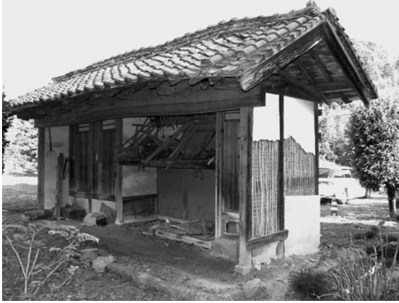
外便所（修復前）
