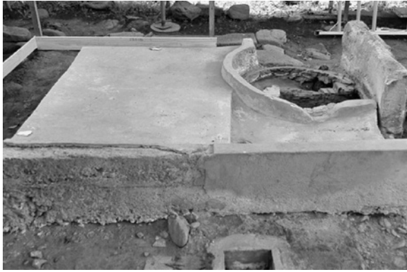
焚屋内部の風呂場（調査解体前）
