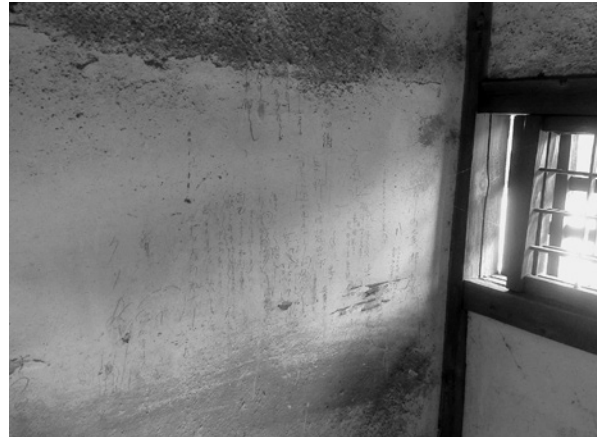
外便所の落書き（東側の内部）
