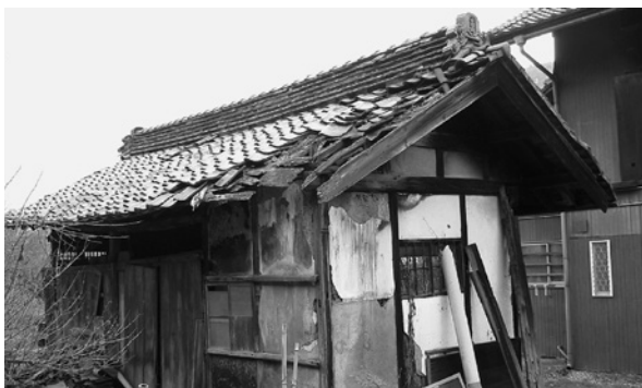
焚屋（修復前・北側より）
