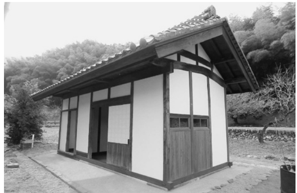
焚屋（修復後・南側より）
