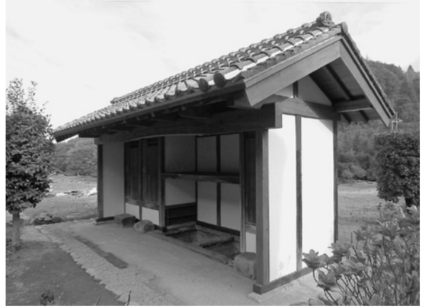
外便所（修復後）
