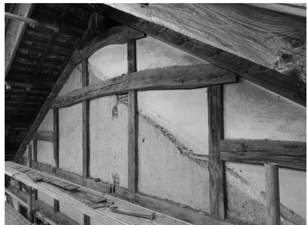
図5 別荘東面に残る香月楼北側屋根部分の痕跡
