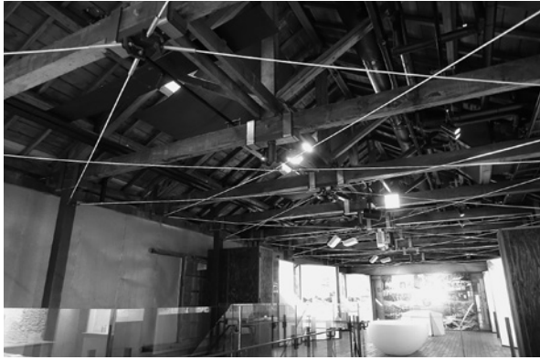
糸をイメージした耐震補強の様子
