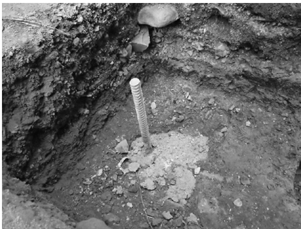
乾燥場・繭扱場 地盤アンカー施工状況
