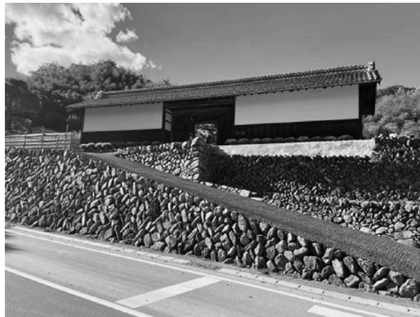
完成した石垣
