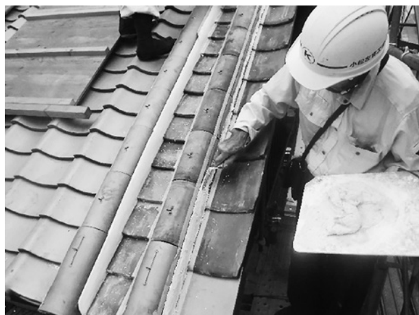
屋根に漆喰を塗る作業
