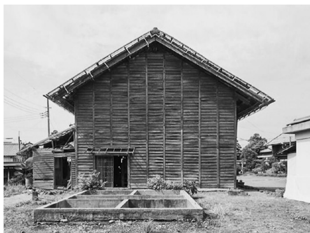
修理前（東側と冷蔵庫跡）
