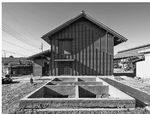
修理後（東側と冷蔵庫跡）
