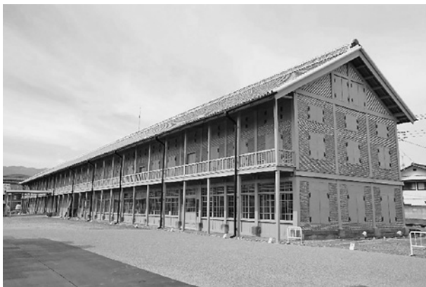
完成後の西置繭所
