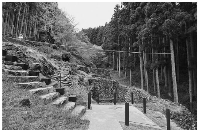
石段下からの眺望 石段の奥にフトンカゴがある
