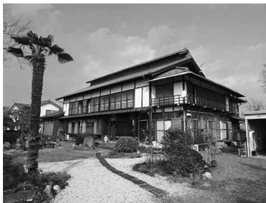
写真4 新たに国の登録有形文化財となった田島達行家住宅主屋
