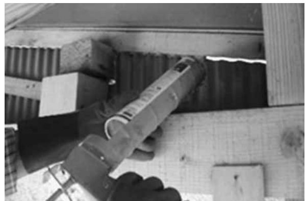
図20 蚕室の隙間を埋める
