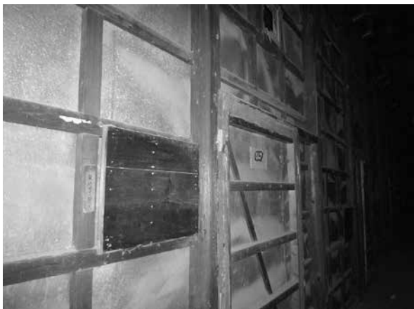
図5 西置繭所2階に残る貯蔵室の扉
