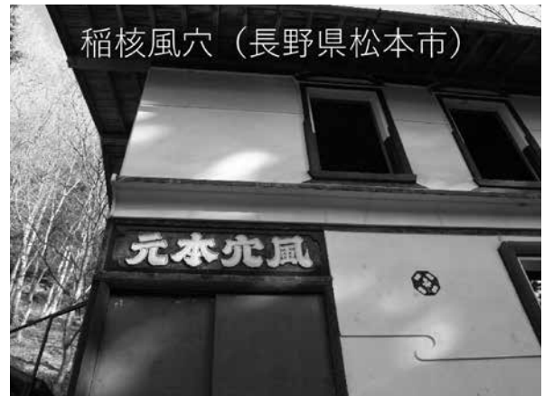
図14 稲核風穴の倉庫
