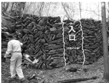
写1-1 同上貯蔵庫石積み正面
