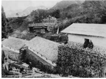
写9 大正6年番舎改修
