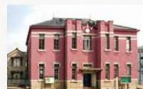
旧模範工場桐生燃糸 合資会社事務所棟(桐生市)
