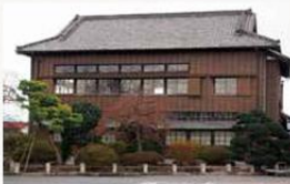
旧碓氷社本社事務所(安中市)
