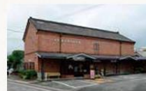
旧小幡組製糸 レンガ造り倉庫(甘楽町)
