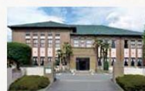
桐生織物会館旧館(桐生市)
